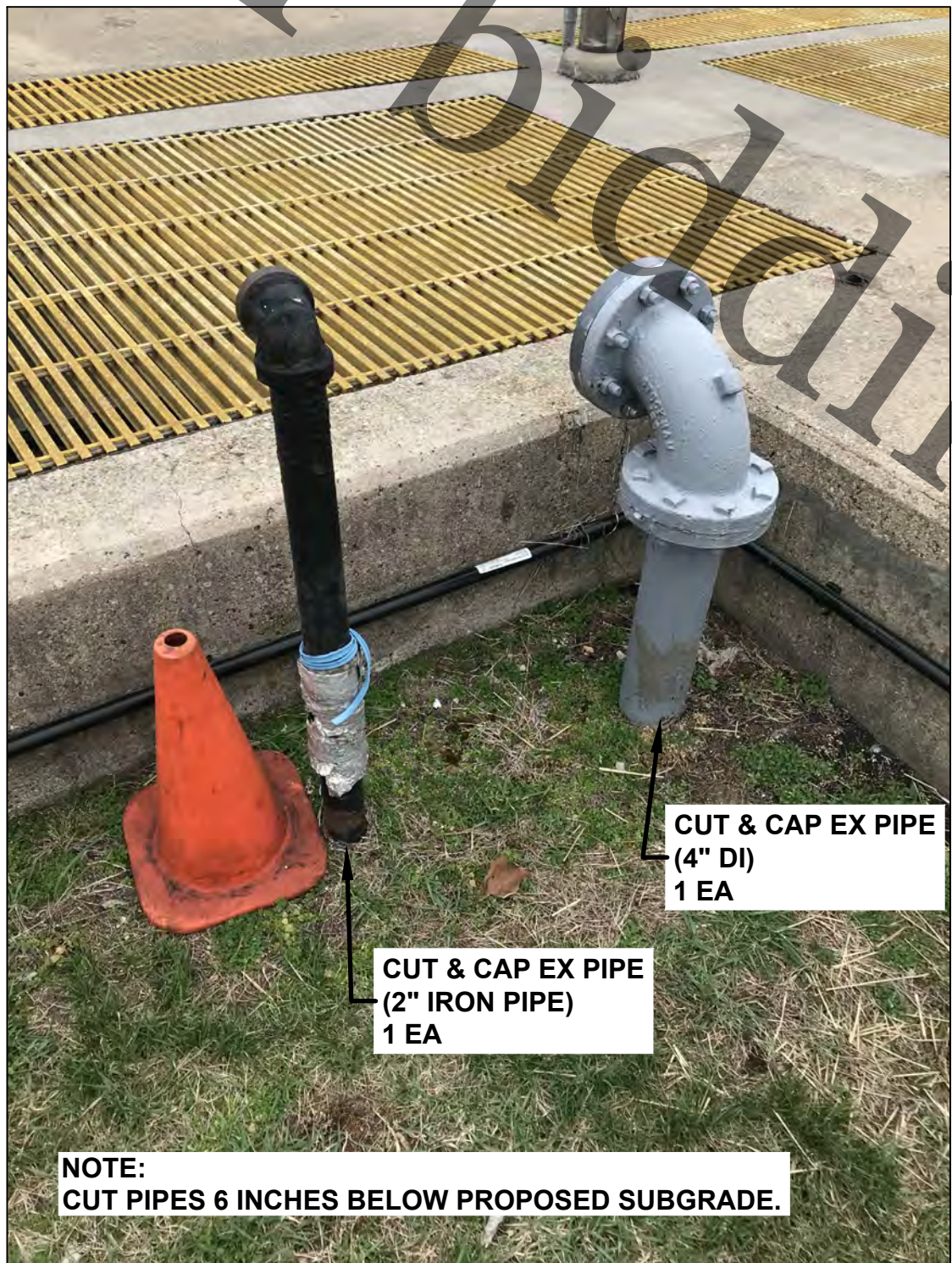
8 CUT & CAP PIPE 4 SCALE: NONE
