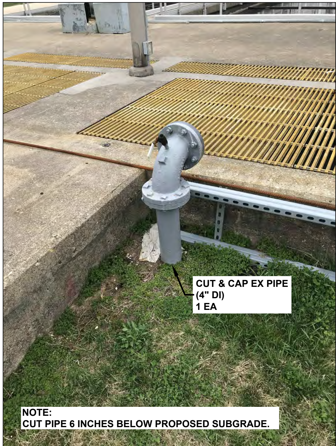
7 CUT & CAP PIPE 4 SCALE: NONE
